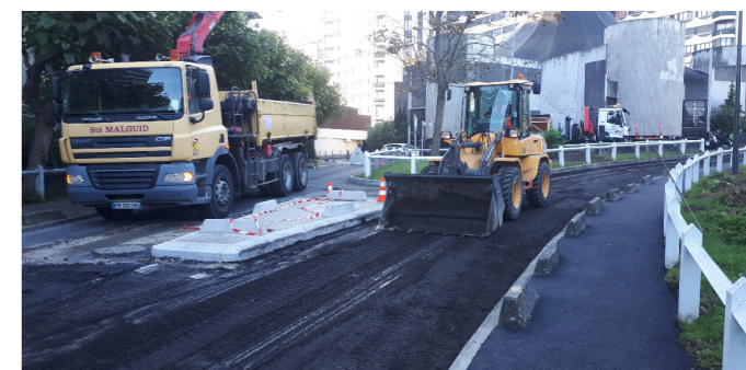
Réhabilitation de la voirie de la rue Vlamincq
